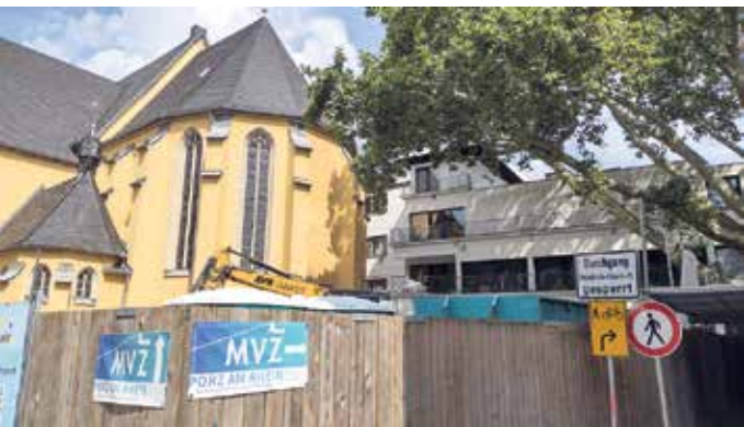
An beiden Seiten ist das Dechant-Scheben-Haus nun umzäunt. Foto: Göllnitz
