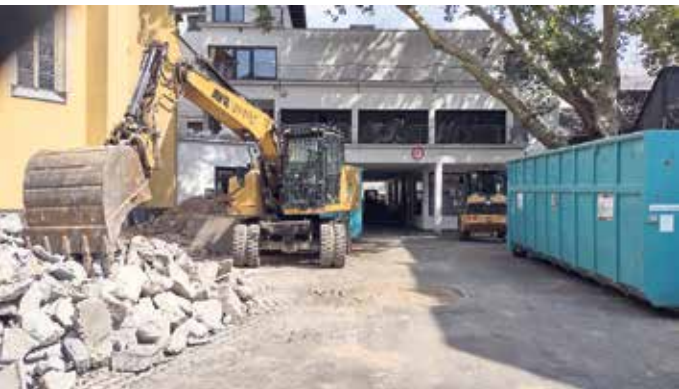
Auch die Umgebung des Abriss-Hauses wird neu gestaltet. Foto: Göllnitz
