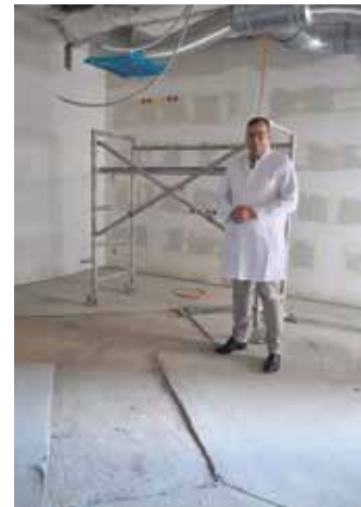
Die Stelle ist im Boden bereits vorbereitet: Prof. Bansmann am Ort des neuen CTs. Foto: Göllnitz
