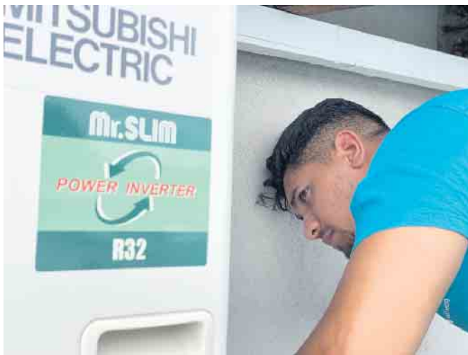
Ein Mitarbeiter der Firma Sanitherm installiert die Außeneinheit einer Klimaanlage.
