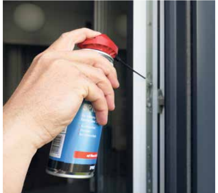
Die Beschlagsteile werden am besten mit einem säure- und harzfreien Öl sparsam geschmiert. Foto: Soudal
