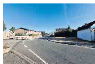
Sicht über den Kurvenbereich deutlich verbessert
