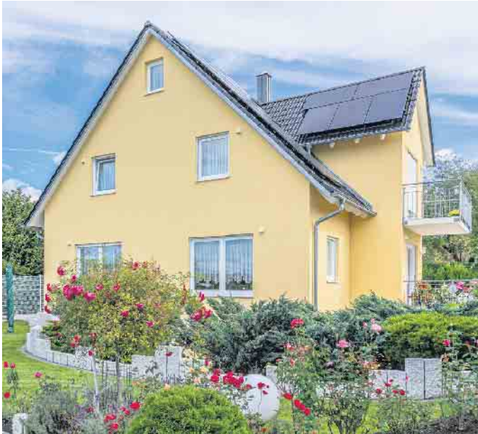
Ob Farben, Putz oder Klinker: Für die Fassadengestaltung können Hausbesitzer aus verschiedenen Möglichkeiten wählen. Foto: djd/Sto/Boris Storz
