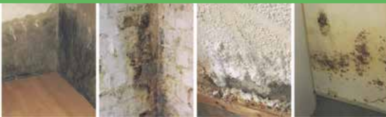
Defekte Horizontalsperre
