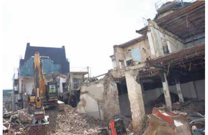
Der Abrissbagger in der Baustelle
