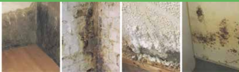
Defekte Horizontalsperre
