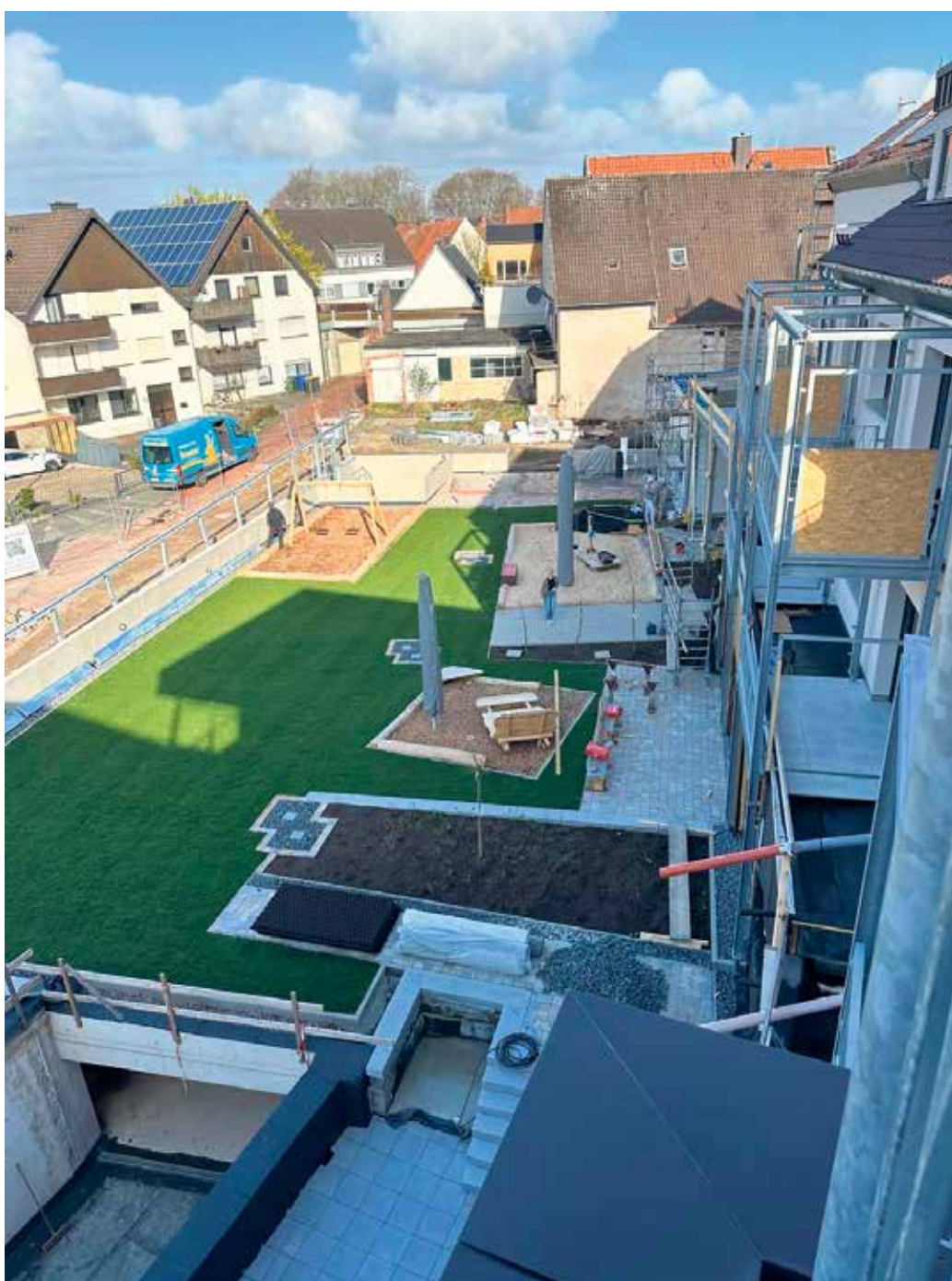
Noch nicht fertig aber schon gut zu erkennen - das Außenspielgelände.
