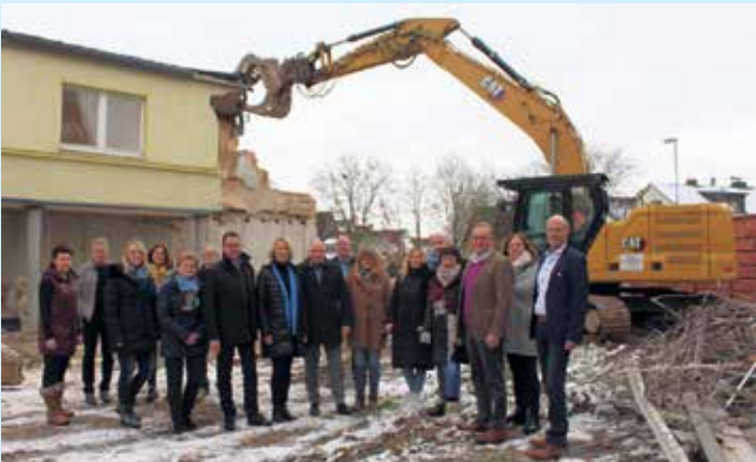
Start der Abrissarbeiten 2023
