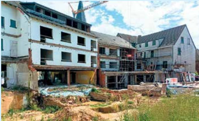
Großbaustelle 2024. Fotos: Margret Sieland
