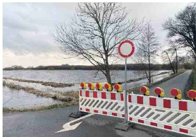
Zahlreiche Straßen rund um den Dümmer See sind aufgrund des Hochwassers gesperrt. Foto: Heidrun Mühlke
