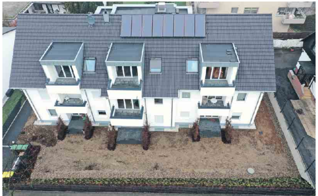
Das Dachdeckerhandwerk, der richtige Ansprechpartner für die Solaranlage auf dem Dach. Foto: ZVDH/akz-o
