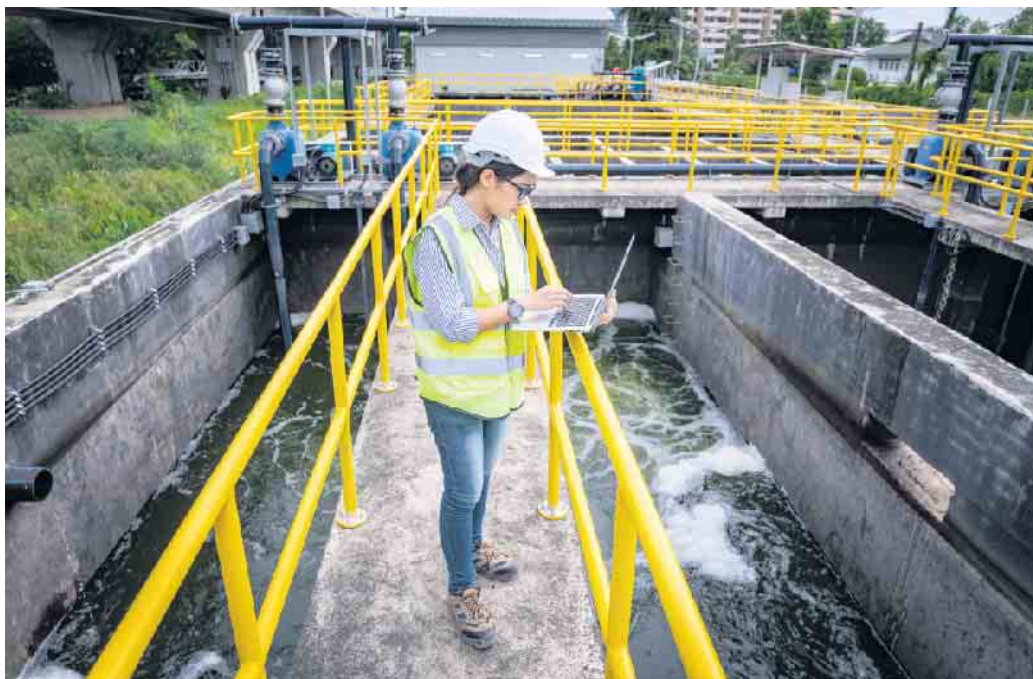
Fachkräfte sichern die Wasser- und Abwasserversorgung als kritische Infrastruktur, schützen die Umwelt und damit unsere Lebensqualität. Foto: DJD/Forum Trinkwasser/APchannel - stock.adobe.com
