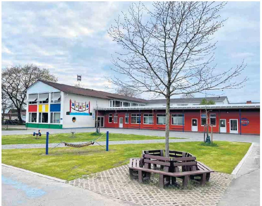
Auf dem Grundschulgebäude in Haldem wird eine der beiden neuen PV-Anlagen installiert. Etwa 80 Prozent des benötigten Stroms kommt damit künftig vom eigenen Dach.
