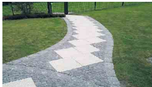
Derselbe Gartenweg nach der professionellen Steinsanierung durch „Steinfresh Deke“.
