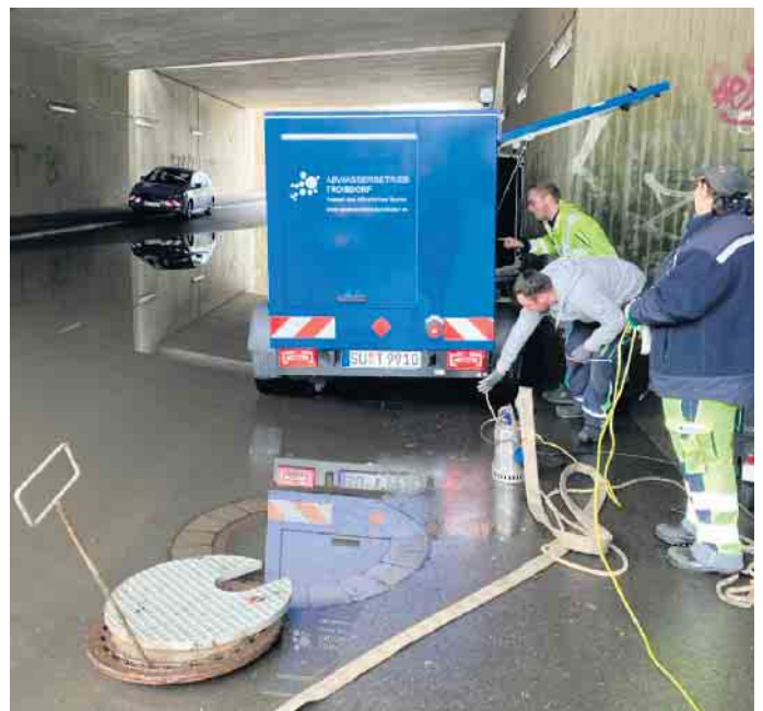
Schnell hat der Abwasserbetrieb Troisdorf, AöR (ABT) in der Unterführung des Willi-Brand-Ringes eine mobile Pumpe errichtet und 72.000 Liter Wasser in die kommunale Kanalisation gepumpt, damit die Straße schnellstmöglich wieder passierbar wurde.
