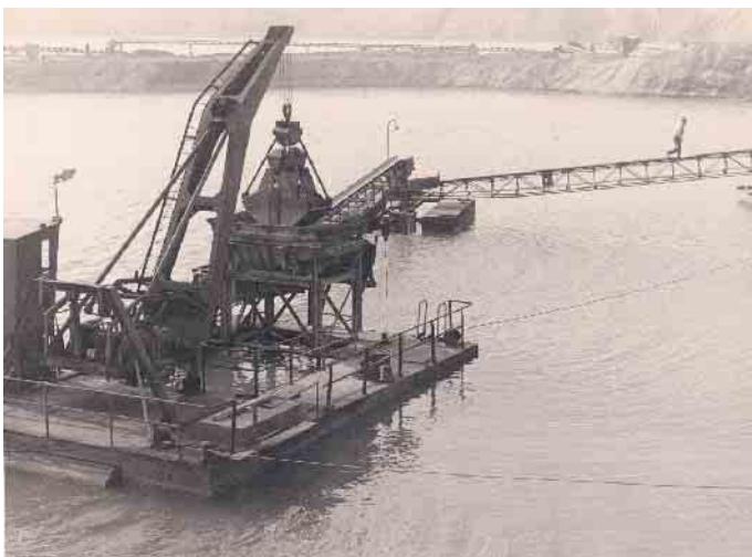
Schwimmbagger und Transportbänder an der Nordseite des Rotter Sees.
