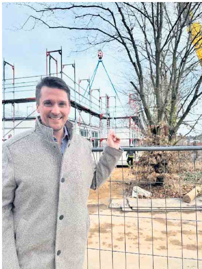
Bürgermeister Alexander Biber überzeugte sich vor Ort vom Baufortschritt
