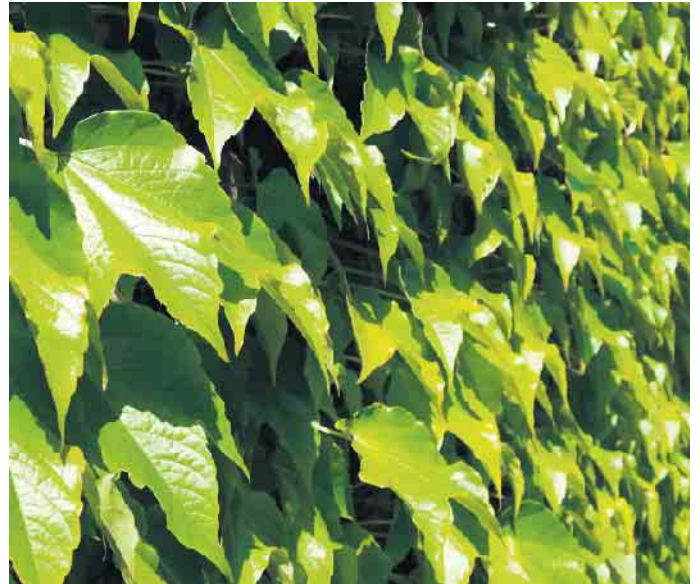
Die klassische Art der Fassadenbegrünung: Wilder Wein wächst an einer Hauswand.
