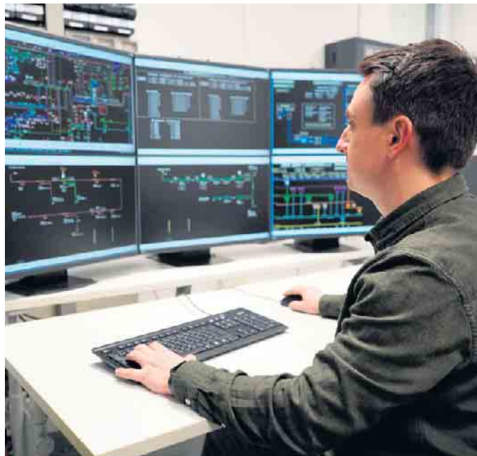
Stadtwerke-Ingenieur Mark Raufuß-Hochstein kontrolliert in der Leitwarte den Zustand der Netzleitstelle.
