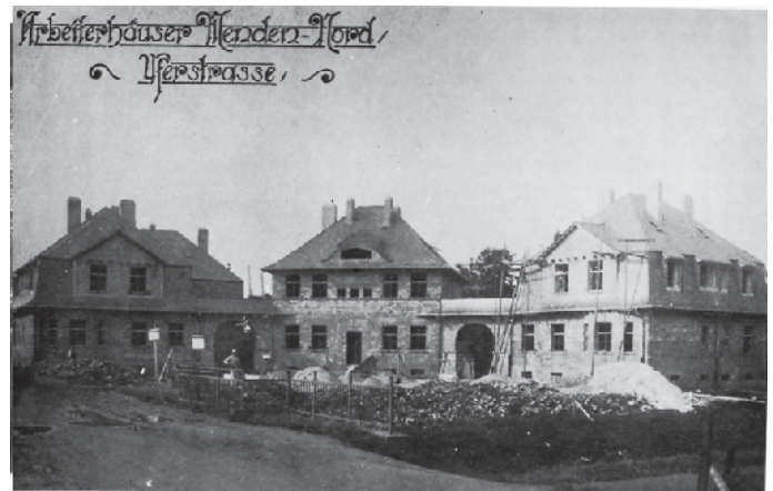
Die „Meister-Häuser“ 1923 an der Uferstraße im Bau
