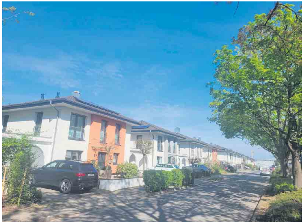
Die »Grüne Kolonie« von Architekt H. W. Piel: Geothermie (Erdwärme) und Solarzellen an der Fritz-Erler-Straße.
