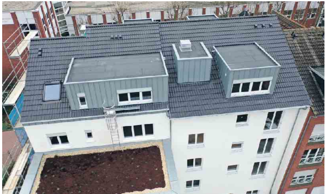
Dachdecker lassen Dächer auch ergrünen. Foto: ZVDH/akz-o
