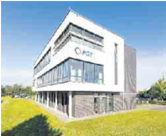
PGT-Firmenzentrale im Camp Spich, Troisdorf
