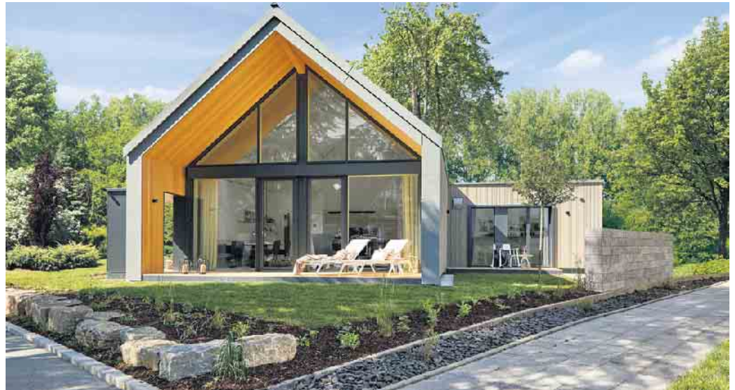
Ein auskragendes Dach schließt die Terrasse in das Gesamtbild des Gebäudes ein und schützt sie vor Witterungseinflüssen. Foto: BDF/Baufritz/Tom Jasny
