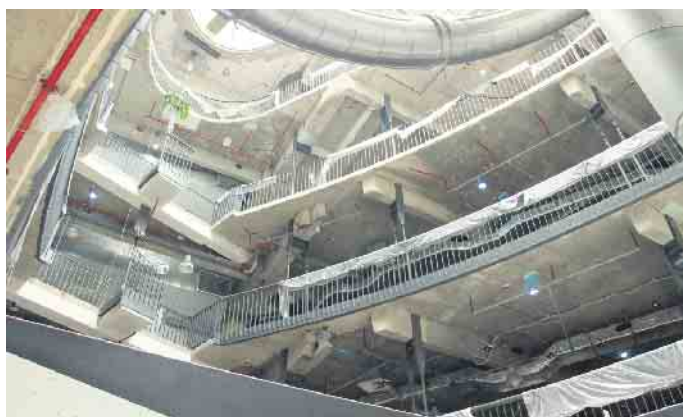
Das Innenleben von Happy Franky vermittelt den Eindruck einer großen Baustelle, vieles wird aber so bleiben. Foto: wed
