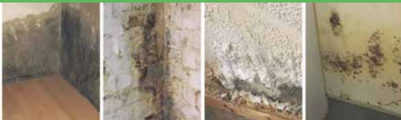
Defekte Horizontalsperre
