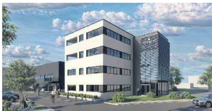
Das Kronenquartier bietet auf vier Etagen modernste Büroflächen und setzt auf nachhaltige Technologien wie eine leistungsstarke Photovoltaikanlage und eine umweltfreundliche Wärmepumpe.
