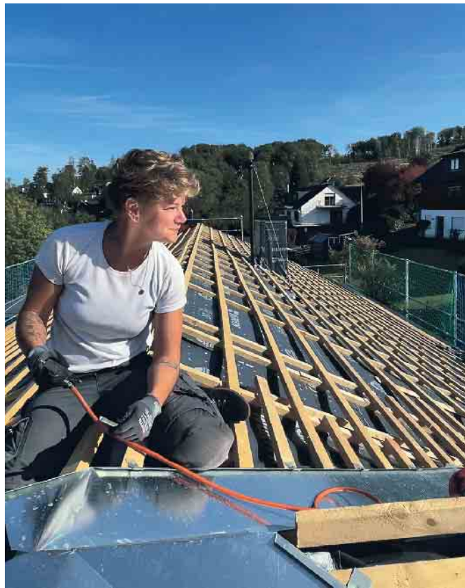
Die Vielseitigkeit des Dachdeckerhandwerk zeigt sich schon in der Ausbildung. Der Beruf erfordert Köpfcchen, Kreativität und Geschick. Foto: ZVDH/akz-o
