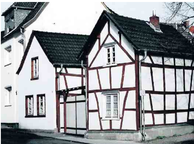
Das denkmalgeschützte Anwesen Rathausstraße 4 und 6.
