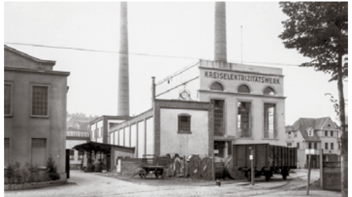
Kreiselektrizitätswerk Dieringhausen Mitte der 1920er-Jahre
