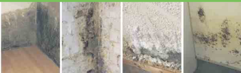
Defekte Horizontalsperre
