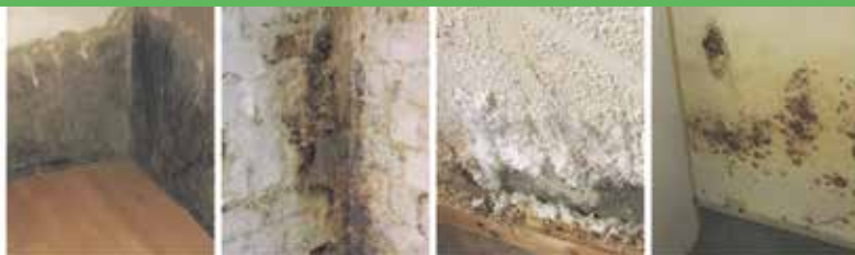
Defekte Horizontalsperre
