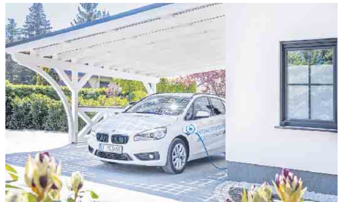
Einmal nachladen, bitte: Das Solarcarport liefert umweltfreundliche Energie beispielsweise fürs E-Auto frei Haus. Foto: DJD/www.solarcarporte.de
