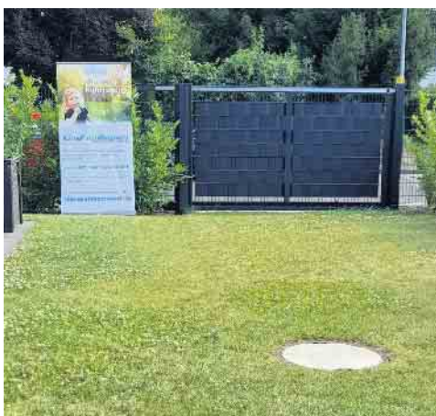
Unter dem Rasen befindet sich das ca. zehn Kubikmeter umfassende Wasserbecken der Eisspeicherheizung. Foto: Andrea Madea
