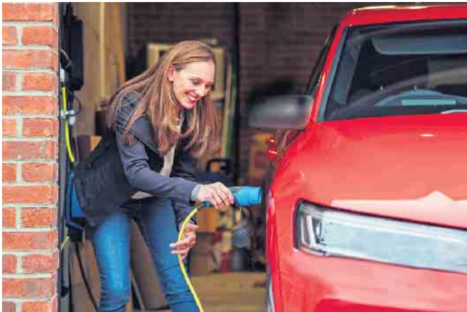
Strom aus der eigenen Garage: Immer mehr Fahrerinnen und Fahrer eines E-Autos lassen sich eine private Wallbox installieren. Foto: djd/AXA Konzern
