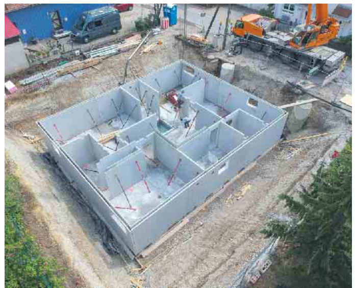
Ein Fertiggeller wird aus industriell vorgefertigten Bauteilen errichtet. Foto: GÜF/Knecht Kellerbau
