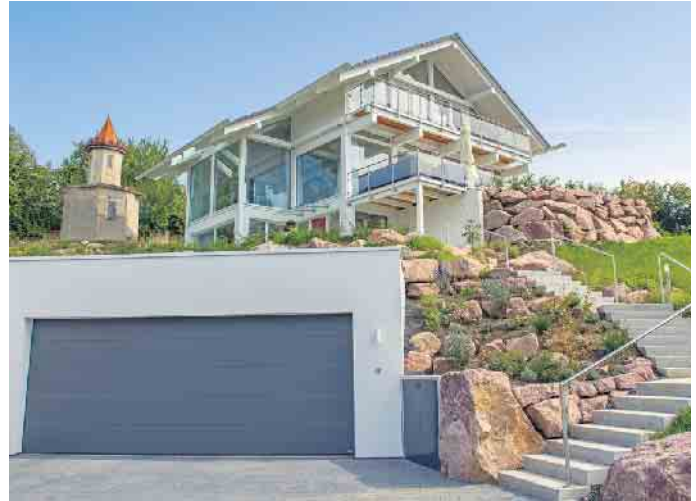
Auf Hanggrundstücken bieten Keller attraktive Möglichkeiten für Stauraum und lichtdurchflutete Wohnräume - wahlweise kombiniert mit einer Garage. Foto: GÜF/Knecht Kellerbau
