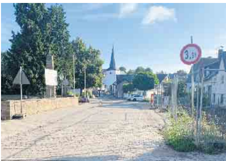
Die Brücke in Metternich wird größer dimensioniert als die bisherige. Foto: Gemeinde Weilerswist
