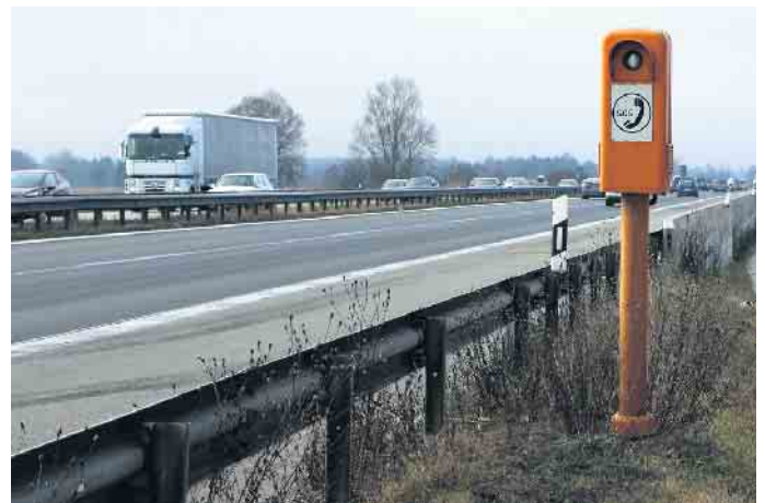
Alle zwei Kilometer steht eine Notrufsäule an der Autobahn. Ein Pfeil und eine Zahl auf den Leitpfosten geben Richtung und Abstand an.
