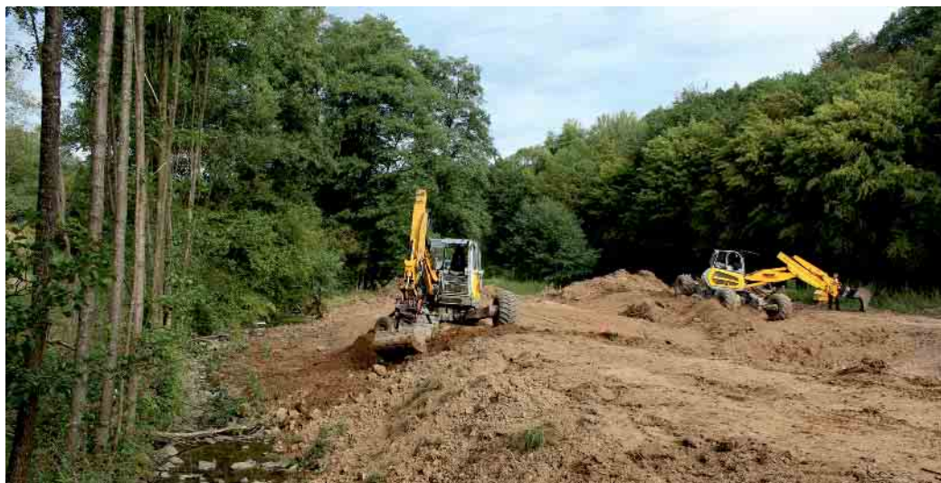
Laufende Gewässerrenaturierung im Krabachtal (Hennef). Foto: Rhein-Sieg-Kreis
