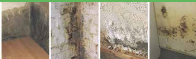
Defekte Horizontalsperre
