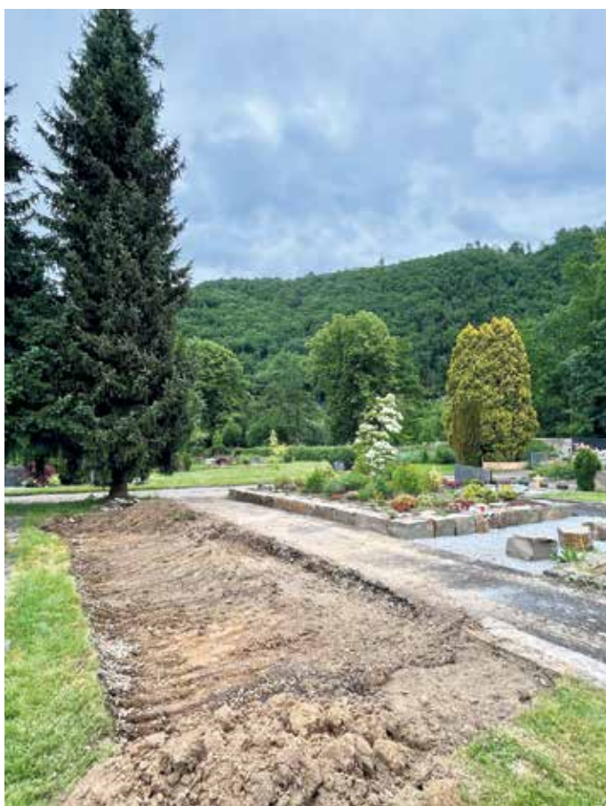
Beginn der Arbeiten
