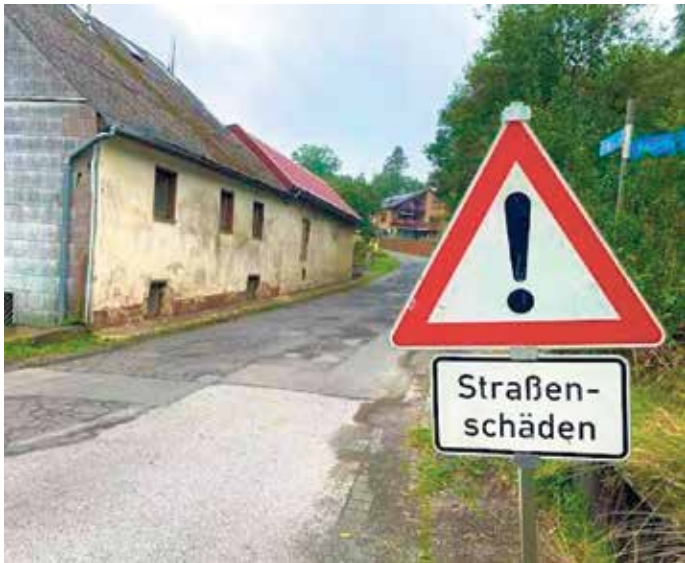
Mit den beschlossenen Planungen werden nun die Grundlagen für eine rechtssichere Entscheidung über mögliche Maßnahmen geschaffen.
