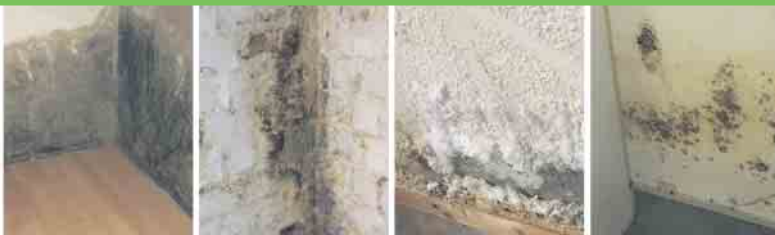
Defekte Horizontalsperre
