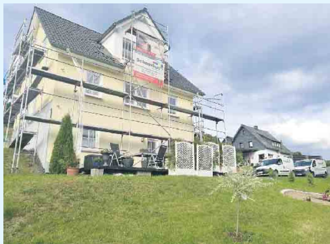
Fassadenarbeiten vom Malerbetrieb Schnorbus
