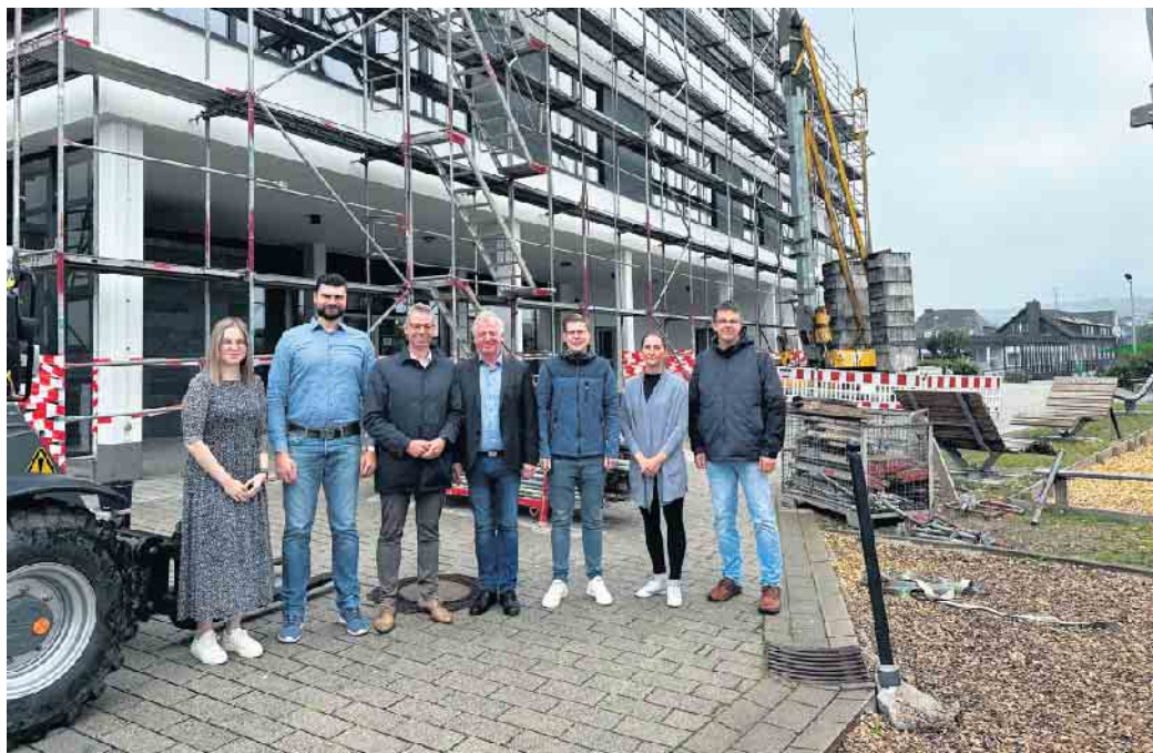
v.l.n.r. Rabea Kappen von der Stadt Winterberg, der stellv. Schulleiter Alexander Sartison, Bürgermeister Michael Beckmann, Schulleiter Uwe Kruse, Geschäftsführer und Projektleiter Dominik Schulte vom Architekturbüro Kotthoff & Partner, Praktikantin
