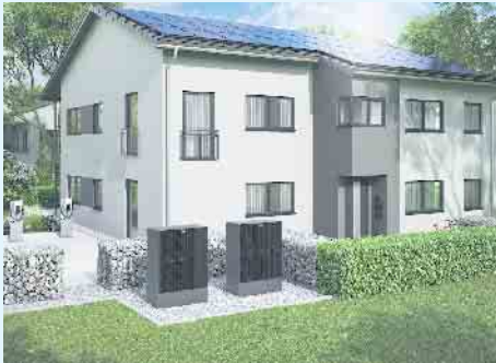
Modernes Mehrfamilienhaus mit Wärmepumpe, PV-Anlage und Wallboxen.
