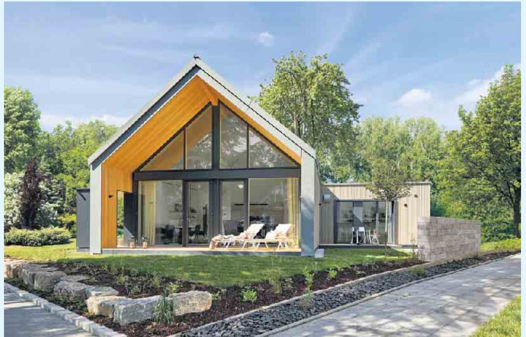
Ein auskragendes Dach schließt die Terrasse in das Gesamtbild des Gebäudes ein und schützt sie vor Witterungseinflüssen. Foto: BDF/Baufritz/Tom Jasny
