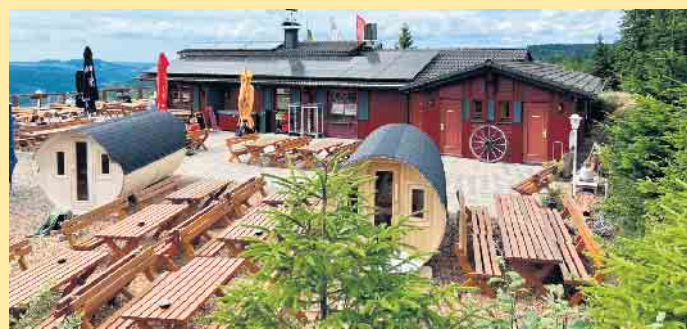
Die Hochheide Hütte und das neu gestaltete Außengelände
