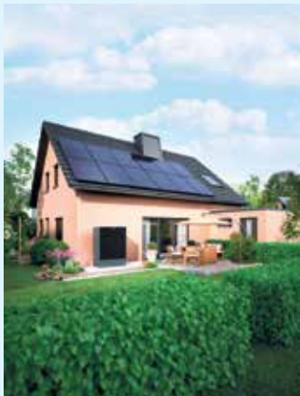
Einfamilienhaus mit modernen Full-Black-Modulen für optimale Aufnahme der Sonnenenergie
