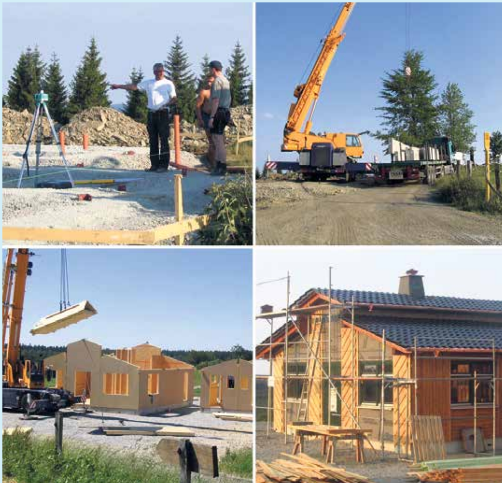
Die Hoheleyer Hütte in der Bauphase
