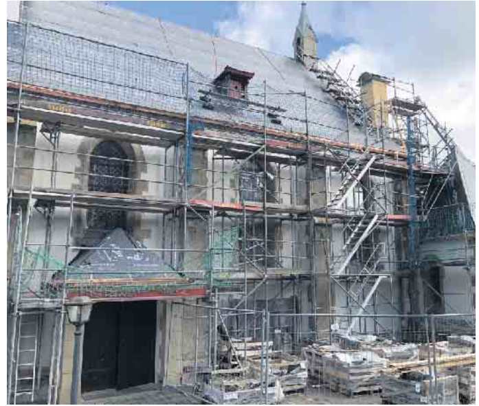
Das eingerüstete Kirchenschiff einschließlich Sakristei.
