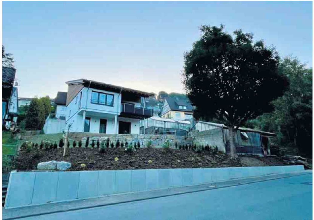
Über das Hof- und Fassadenprogramm können z.B. Stützmauern gefördert werden - hier ein Beispiel aus Niedersfeld.
